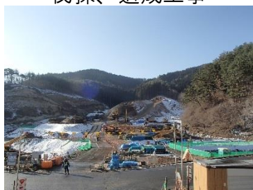
伐採、造成工事
